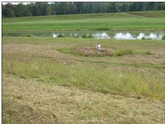
T 15: Udubina uz priobalnu nožicu nasipa izdužene forme paralelne pružanju kanala, dimenzija 8x3 metra i dubine 30-70 cm.
