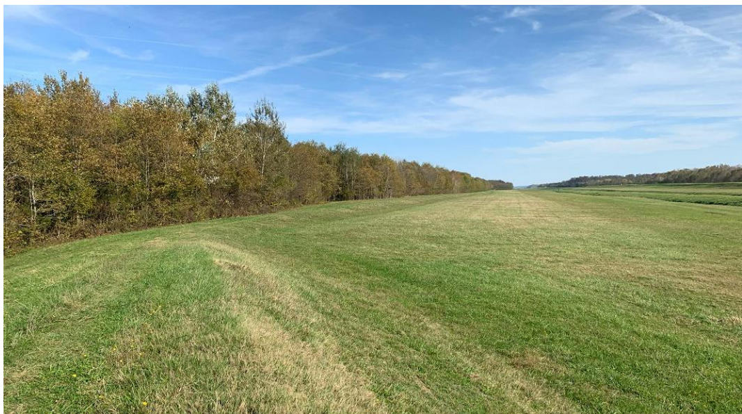
Slika 3. Prikaz lijevog nasipa kanala Kupa-Kupa na području bočnoga preljeva u 6. km
