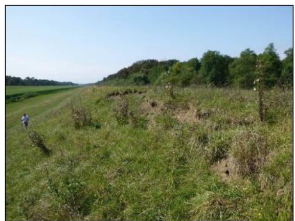
T 16: Zona klizišta na probalnoj i zaobalnoj strani nasipa. Klizanjem su zahvaćeni pokosi nasipa u duljini od 20 do 70 metara. Mjestimično je klizanjem zahvaćen i dio krune nasipa. Skok u čelu klizišta iznosi približno 1,5 m.
