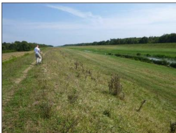
T 16: Zona klizišta na probalnoj i zaobalnoj strani nasipa. Klizanjem su zahvaćeni pokosi nasipa u duljini od 20 do 70 metara. Mjestimično je klizanjem zahvaćen i dio krune nasipa. Skok u čelu klizišta iznosi približno 1,5 m.
