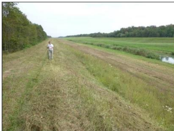
T 14: Slijeganje po cijeloj širini krune nasipa dubine 40 cm i na duljini krune od 20-ak metara. Slijeganje je djelomično vidljivo i u gornjem dijelu priobalnog pokosa.
