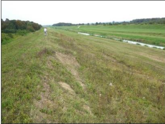
T 13: Niz od nekoliko uzastopnih klizišta na priobalnom pokosu nasipa. Cijela zona klizanja dugačka je preko 120 m.
