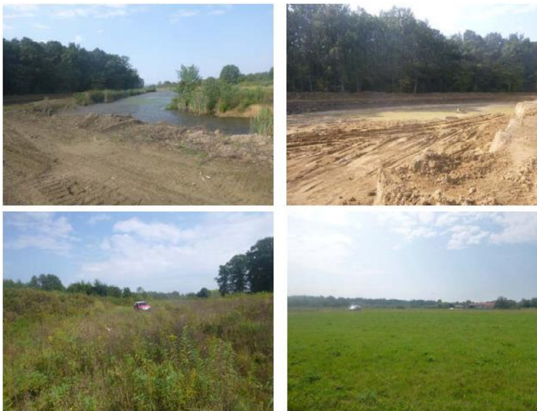
Slika VI-5 Nalazište materijala, lokacija prokopa Korana-Kupa
