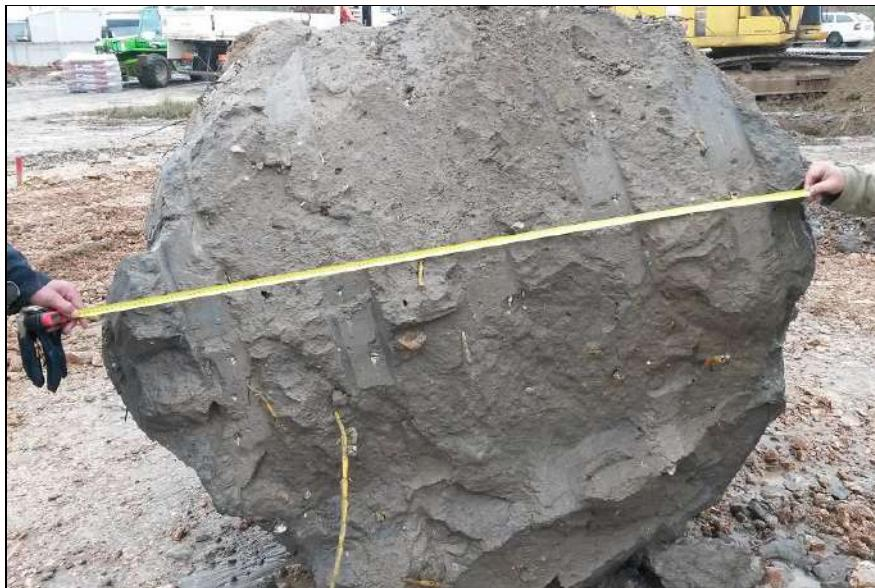
Slika 17 - Odlomljeni presjek izvedenog stupnjaka
