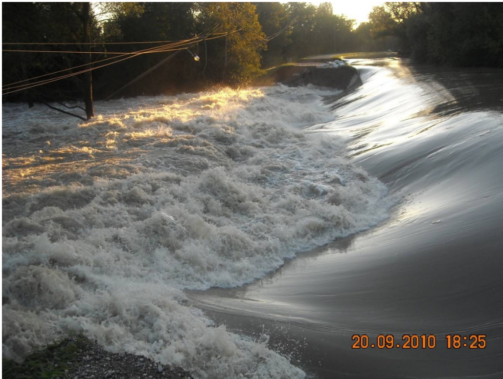
Sl. 2.2. Proboj savskog nasipa kod Strmca Bukevskog na velikogoričkom području (2010.)
