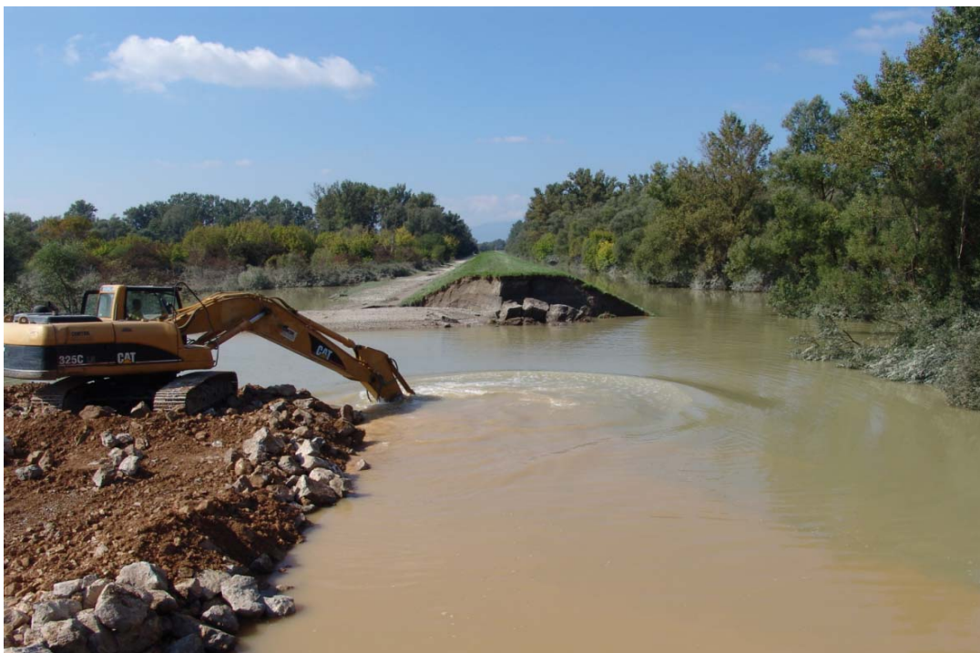
Sl. 2.3. Hitna intervencija nakon proboja savskog nasipa kod Strmca Bukevskog (2010.)
