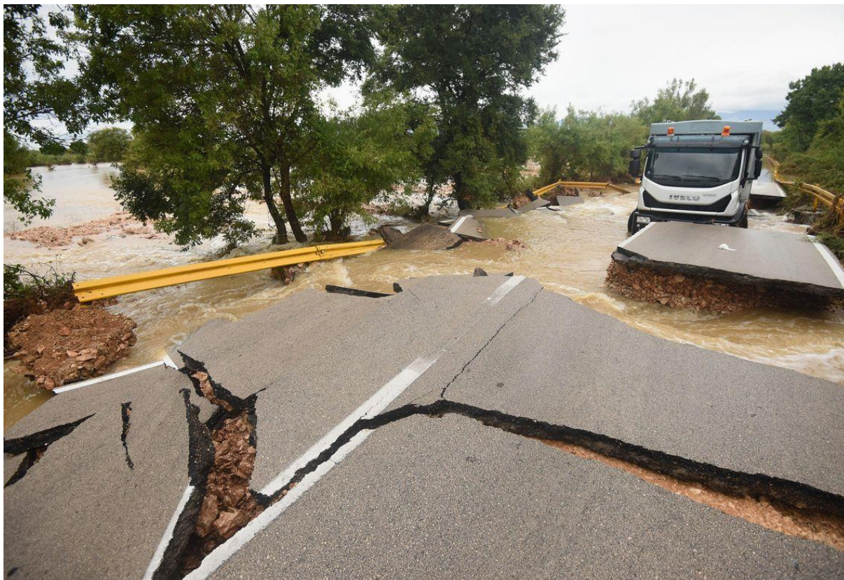
Slika 28 Oštećenje ceste Zadar - Ražanac, 11. rujan 2017. godine
