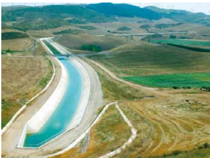
Slika 7. Pogled na dio Canala Navarra
