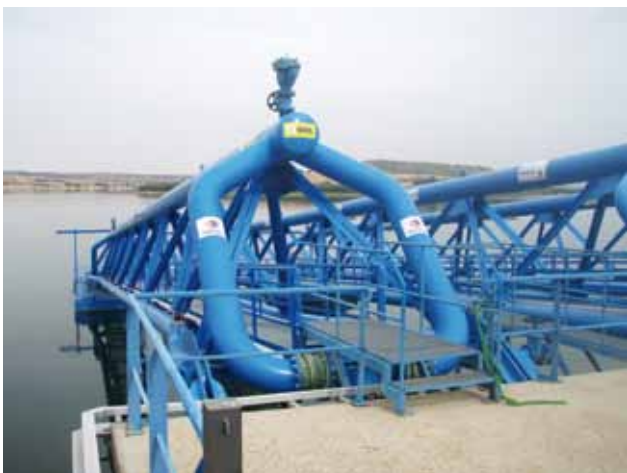
Slika 3. Fleksibilni zahvat code iz postojeće akumulacije za potrebe realizacije projekta PEBEA
