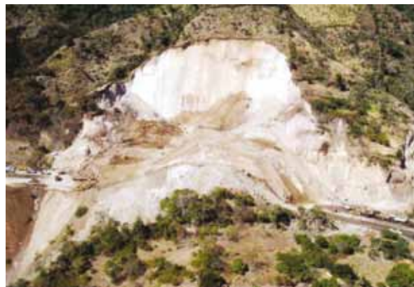
Slika 7 Klizište izazvano iskopom zasjeka za cestu u nožici padine na rubu stabilnosti
