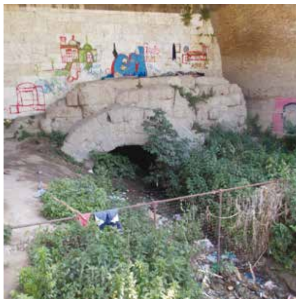
Slika 13: Zapušteni ispust i tri koncentrična reda blokova u luku koji ga okružuju (snimio J. Rubeša).
