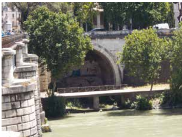
Slika 12: Lokacija ispusta Cloace Maxime u rijeku Tiber pored mosta Ponte Palatino (snimio J. Rubeša).
