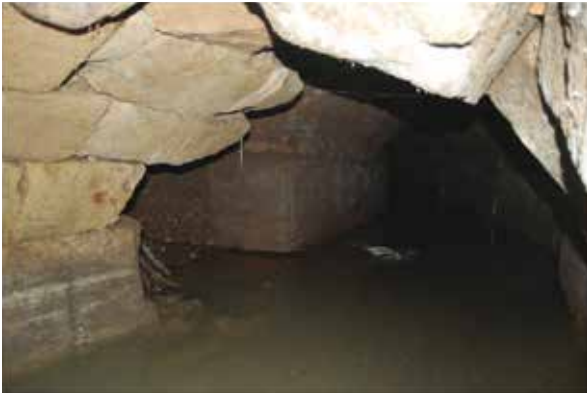
Slika 6: Y-spoj Cloace Maxime između ranog i kasnog republikanskog te starog poteza s popravcima (Hopkins, 2007.).
